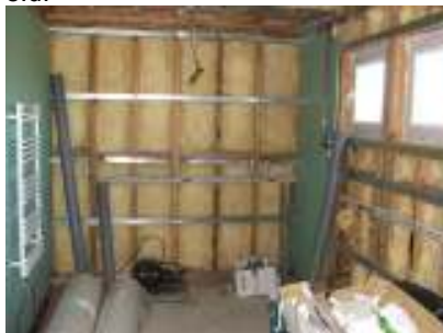
Binnenwanden in voorbereiding
